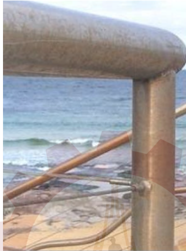
รูปที่ 2.42 ลักษณะการเสื่อมสภาพของสแตนเลส
